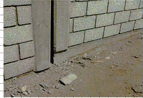
• Castillo de concreto armado
