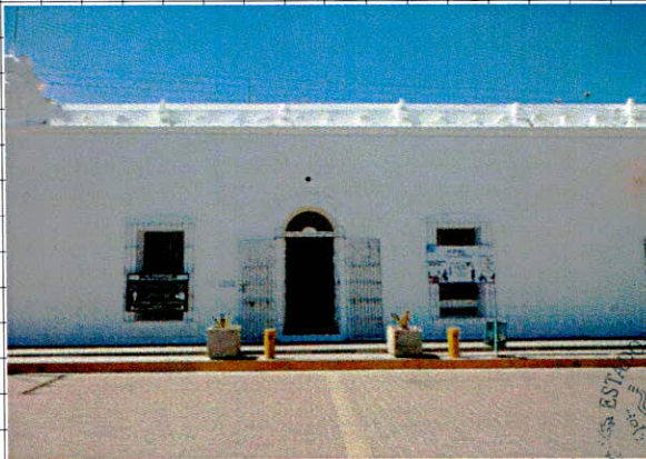
• Suministro y aplicación de pintura en muros.
