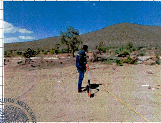
•Formacion y compactacion: de terraplenes adicionados con sus cuñas de sobrancho
