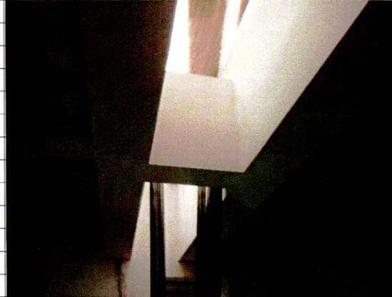
• Falso plafond a base canaleta y tablaroca mano de obra material, desmontajes, acarreo dentro y fuera de obra
