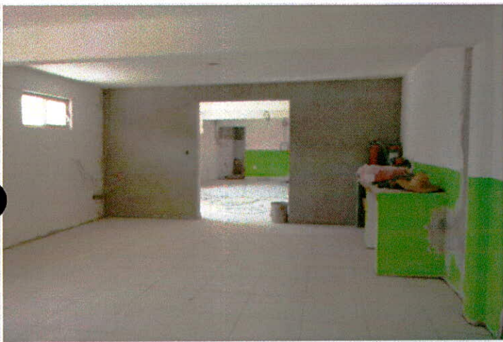
• Aplanado fino en muros a plomo y regla
