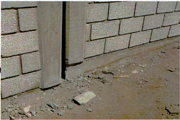
• Castillo de concreto armado
