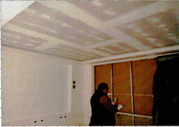
• Falso plafond a base canaleta y tablaroca mano de obra material, desmontajes, acarreo dentro y fuera de obra
