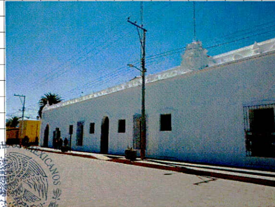
• Suministro y aplicación de pintura en muros.
