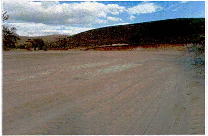
•Formacion y compactacion: de terraplenes adicionados con sus cuñas de sobreencho
