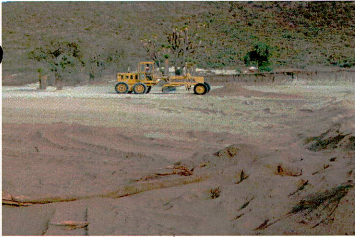
• Mezclado, tendido y compactacion de la capa subrasante formada con material seleccionado
