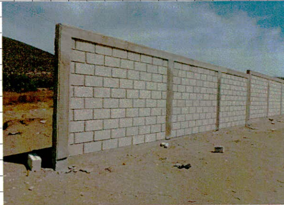
• Dala o cadena de desplante, incluye cimbra y descimbra seccion =15x20 cm, concreto FC=200 kg/cm22-3/4, reforzada con 4 varillas de RN de 3/8 estribos de 1/4 A/C 30 cm
