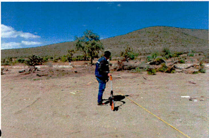
•Formacion y compactacion: de terraplenes adicionados con sus cuñas de sobreencho
