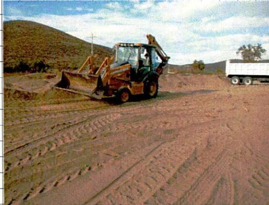
• Mezclado, tendido y compactación de la capa subrasante formada con material seleccionado
