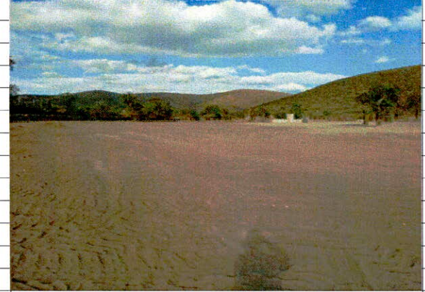
•Formacion y compactacion: de terraplenes adicionados con sus cuñas de sobrancho
