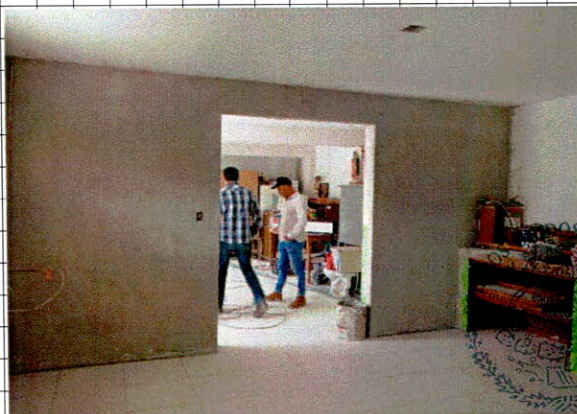
• Aplanado fino en muros a plomo y regla
