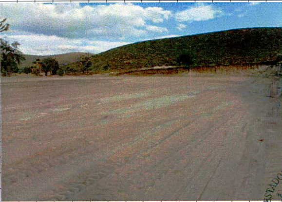
•Formacion y compactacion: de terraplenes adicionados con sus cuñas de sobrancho
