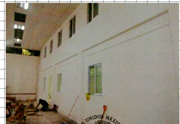
• Suministro y colocación de cancelaria de aluminio anodizado natural
