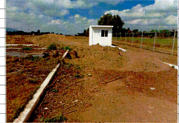
• Limpieza de terreno para el area exterior
