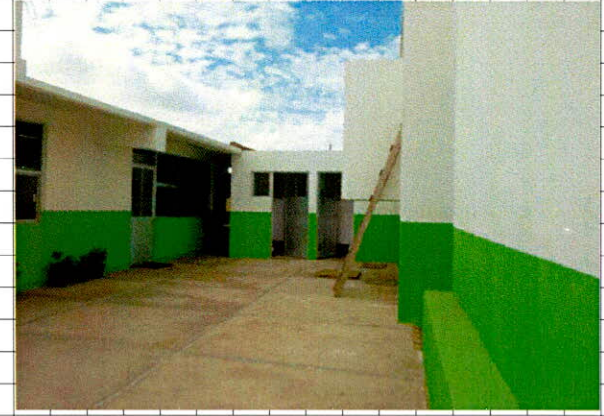
• Suministro y aplicación de pintura vinilica comex 100 sobre muros y plafones de yeso
