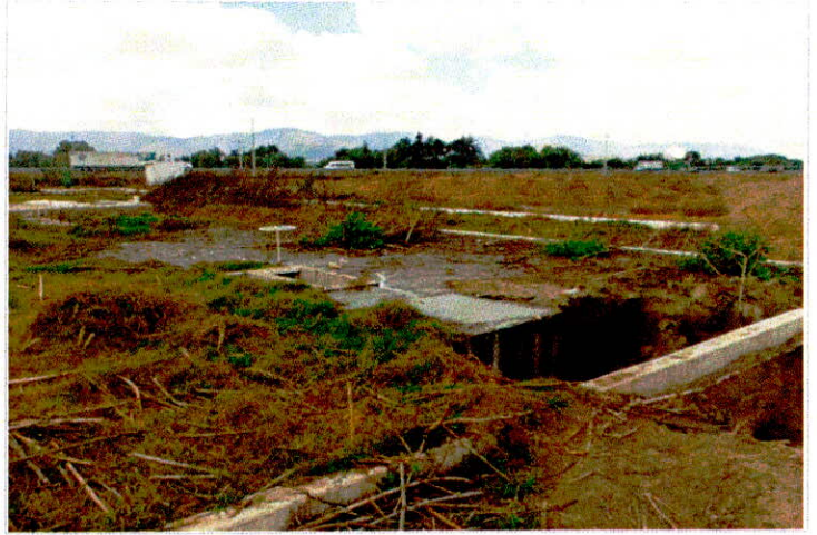
• Desazolve de fosa septica por m3
