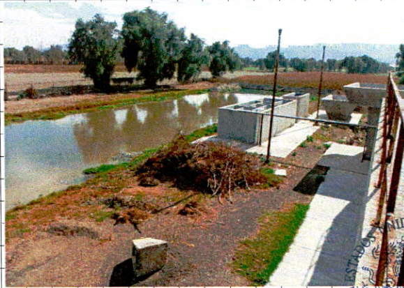
• Limpieza de terreno para el area exterior, incluye: despalme y desenraizado de capa vegetal.
