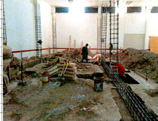
• Concreto echo en obra resistencia rapida vaciado con carretilla en botes FC=250 KG/CM2
