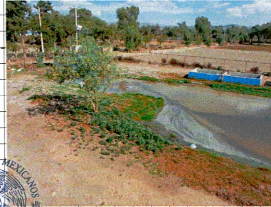
• Limpieza de terreno para el area exterior, incluye: despalme y desenraizado de capa vegetal.
