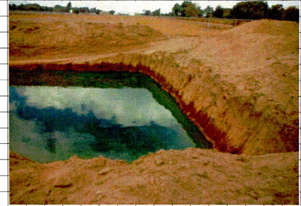
• Excavacion en zanjas con equipo (retroexcavadora), en material comun seco.
