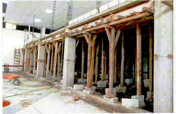
• Cimbrado y descimbrado comun en traves
