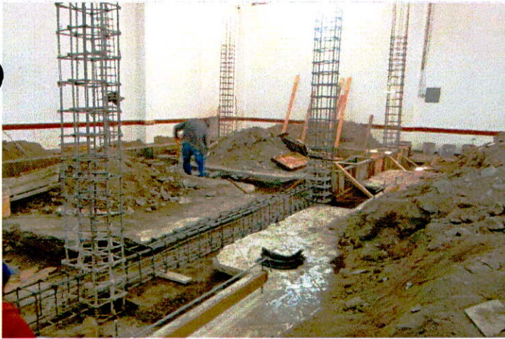
• Suministro, habilitado, armado y colocado de acero de refuerzo en estructura resistencia nominal FY=4200
