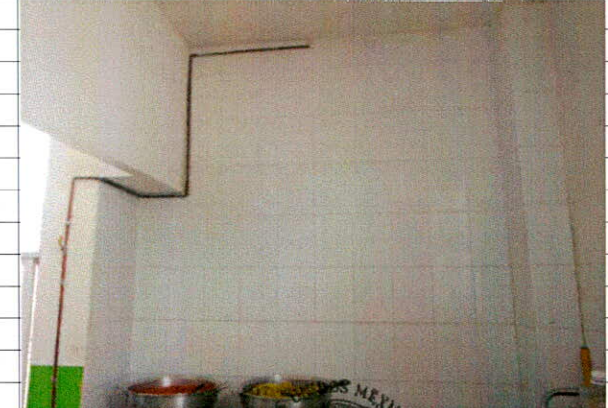
• Suministro y colocación de muros tablaroca de 4.3 cm 60 espesor
