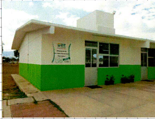
• Suministro y colocacion de luminaria tipo capcee con gabinete
