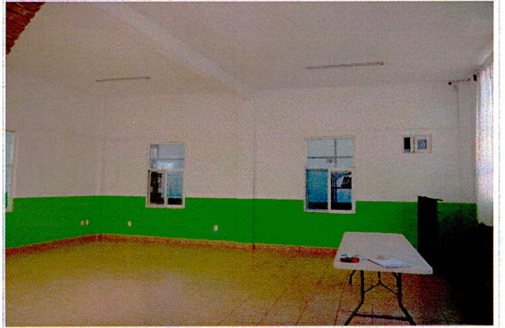
• Suministro y aplicación de pintura sobre muros y plafones de yeso
