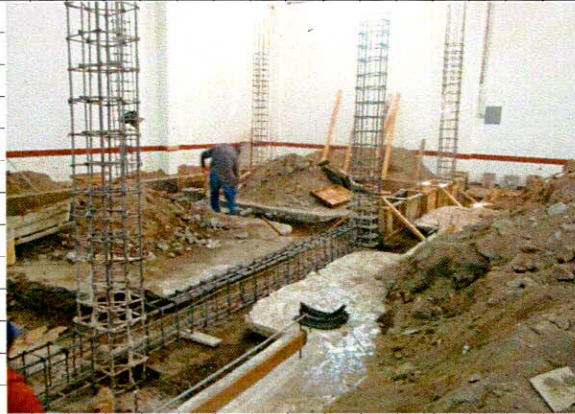
• Suministro, habilitado, armado y colocado de acero de refuerzo en estructura resistencia nominal FY=4200
