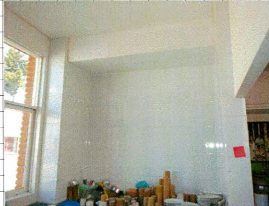
• Suministro y colocación de azulejo blanco de primera asentado con mortero Cem-are 1:5
