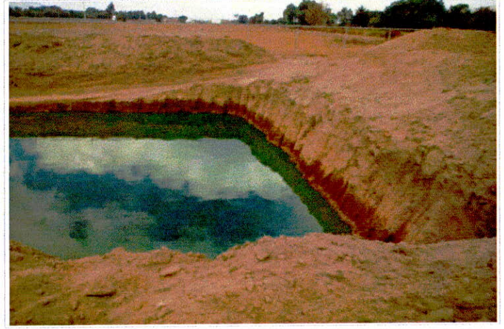
• Excavacion en zanjas con equipo (retroexcavadora), en material comun seco.
