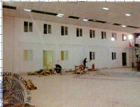
• Aplanado fino en muros a plomo y regla de kortero cemento-arena 1:3 espesor promedio = 2.5 cm incluye repellido pulido con plana
