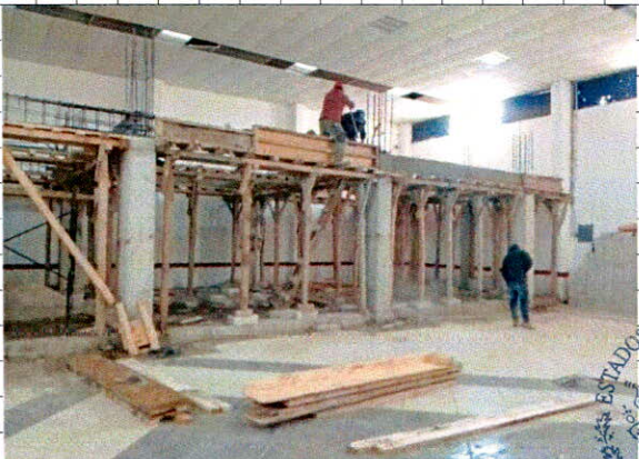
• Cimbrado y descimbrado comun en trabes
