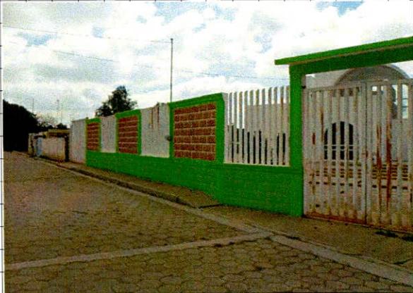
• Suministro y aplicación de pintura esmalte alkidalen herreria por 2 lados
