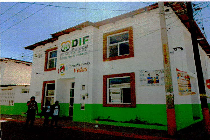
• Suministro y colocación de puertas de aluminio
