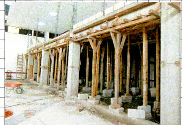
• Cimbrado y descimbrado comun en trabes
