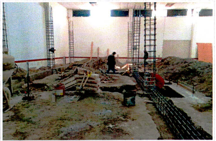
• Concreto echo en obra resistencia rapida vaciado con carretilla en botes FC=250 KG/CM2
