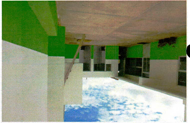
• Suministro y aplicación de pintura vinílica comex 100 sobre muros y plafones de yeso
