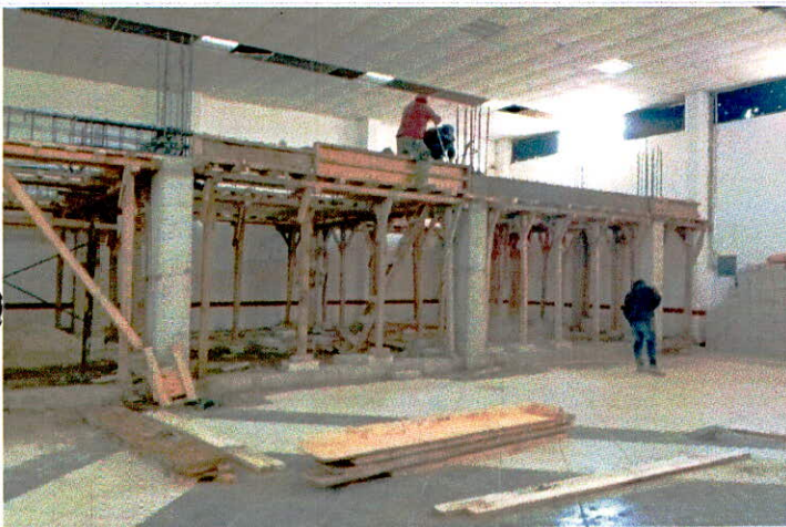
• Cimbrado y descimbrado comun en traves
