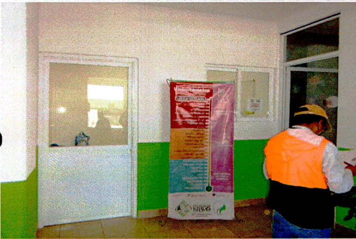
• Suministro y aplicación de pintura sobre muros y plafones de yeso
