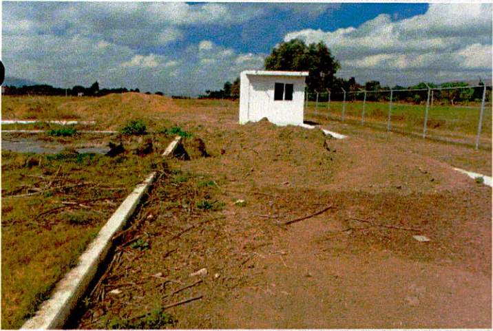
• Limpieza de terreno para el area exterior
