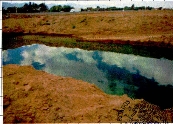
• Excavacion en zanjas con equipo (retroexcavadora), en material comun seco.
