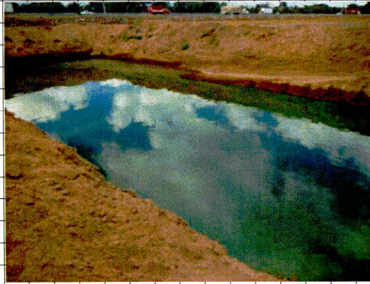
• Excavacion en zanjas con equipo (retroexcavadora), en material comun seco.
