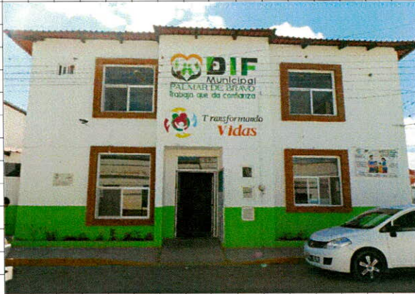
• Suministro y aplicación de pintura sobre muros y plafones de yeso
