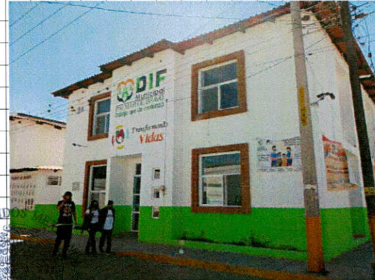
• Suministro y colocación de puertas de aluminio
