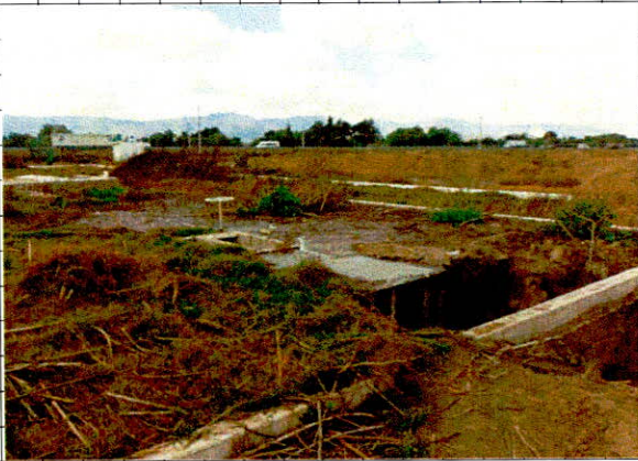
• Desazolve de fosa septica por m3
