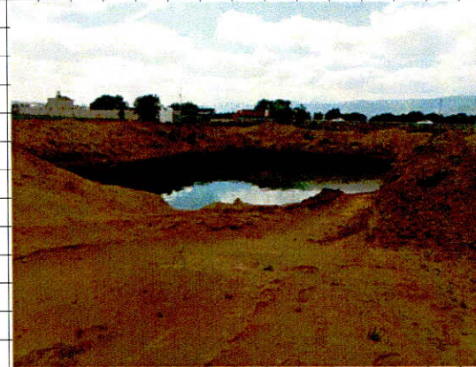
• Limpieza de terreno para el area exterior
