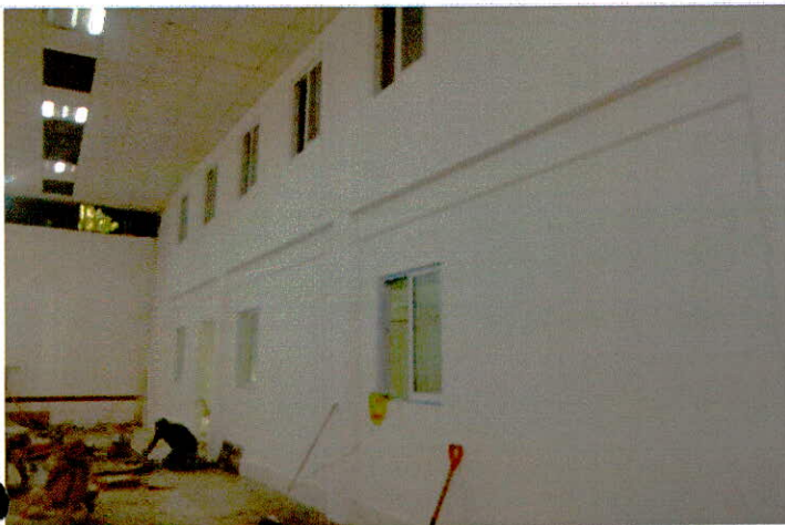
• Aplanado fino en muros a plomo y regla de kórtero cemento-arena 1:3 espesor promedio = 2.5 cm incluye repellido pulido con plana
